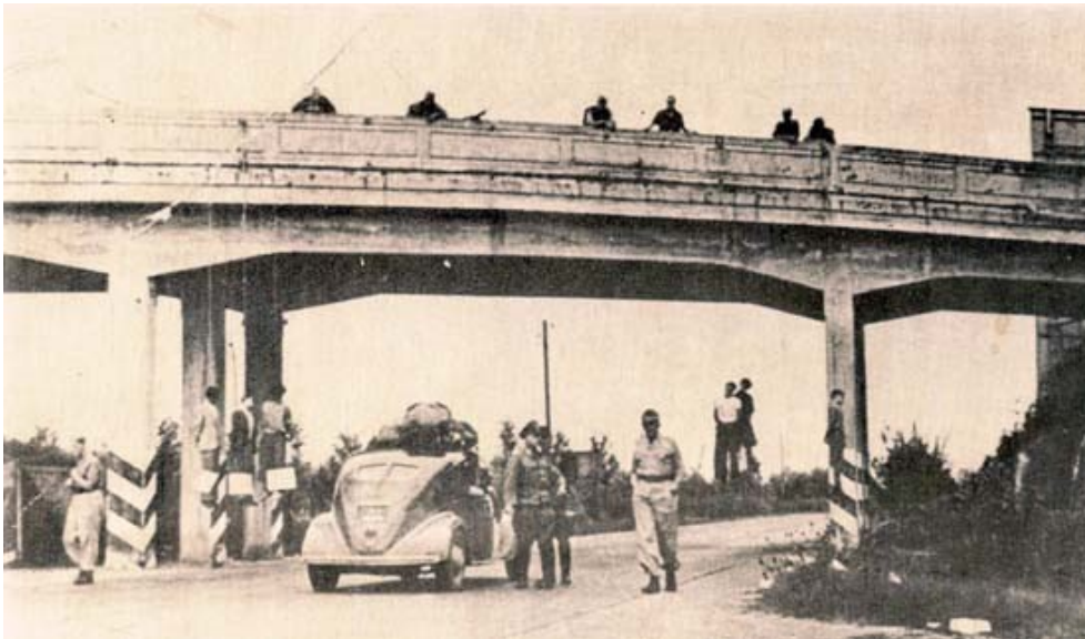
Il cavalcavia autostradale di Settimo Torinese
