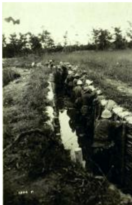
Fig. 3 - Trincea scoperta con suolo non protetto ed allagato. A differenza di quelle più arretrate, le trincee di prima linea erano generalmente scavi provvisori, effettuati di notte, spesso privi di adeguato drenaggio del terreno. In queste condizioni le trincee erano frequentemente allagate o comunque piene di fango, poiché divenivano inevitabilmente canali di raccolta delle acque piovane e di quelle del terreno circostante (fotografia del Museo Centrale del Risorgimento, Roma, collocaz. MCRR Album Fp 4 155).
