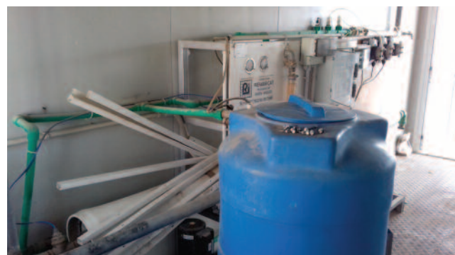
Fig. 2 - Potabilizzatore in disuso.
