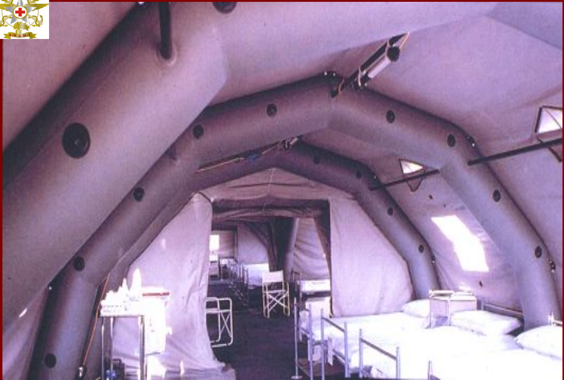
Tenda pneumatica – Struttura Interna 1° Costruzione 06/1988 - 1° Impiego 09/1988
