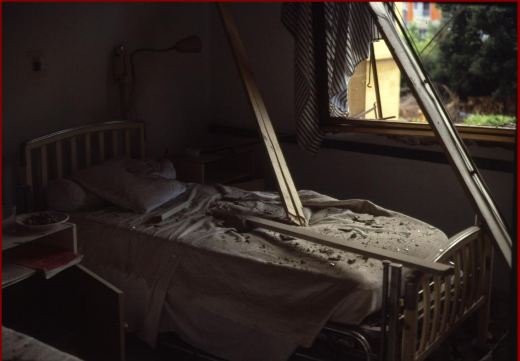
Ospedale da Campo n. 1 mod 65 Danni a struttura sanitaria civile – 3° anello logistico Attacco missilistico
