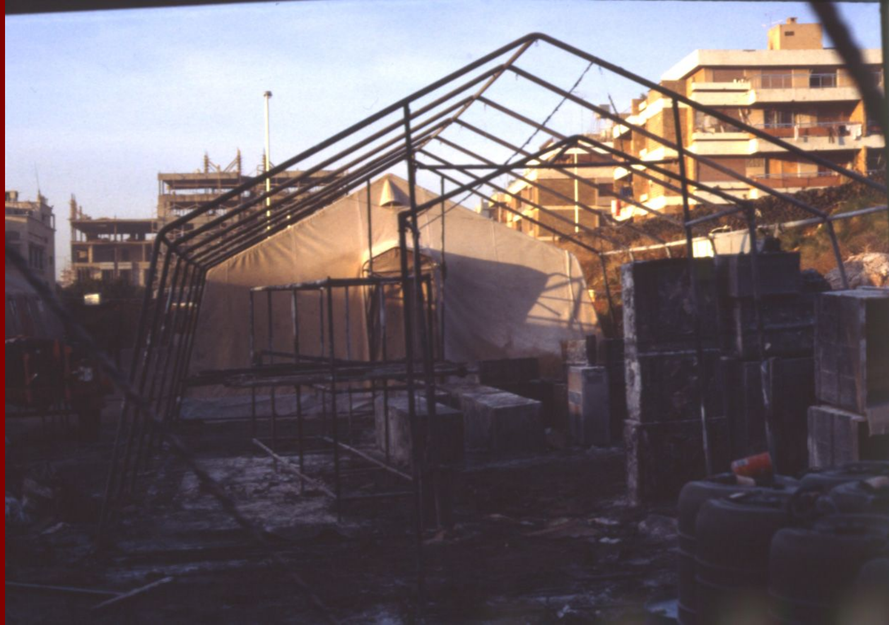
Ospedale da Campo n. 1 - mod 65 Danni a strutture – Incendio di una tenda per colpo incendiario In un giorno di ordinario combattimento
